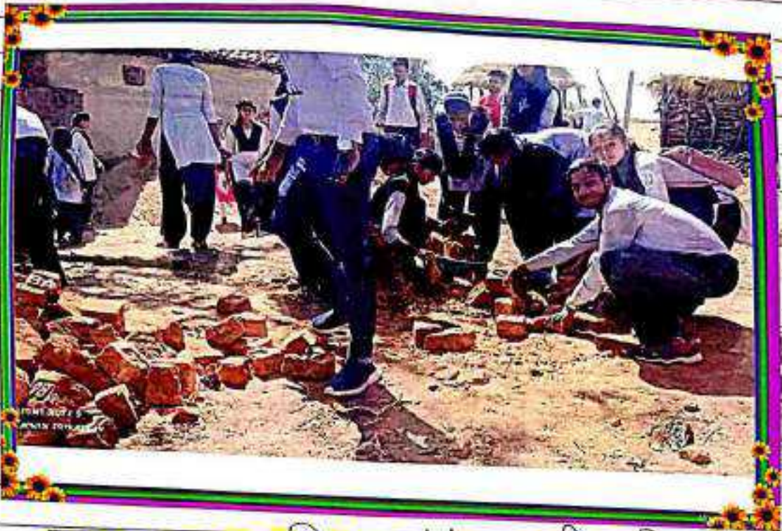
ग्राम - वरुनिया में नाली निर्माण कर रहे हुए।
